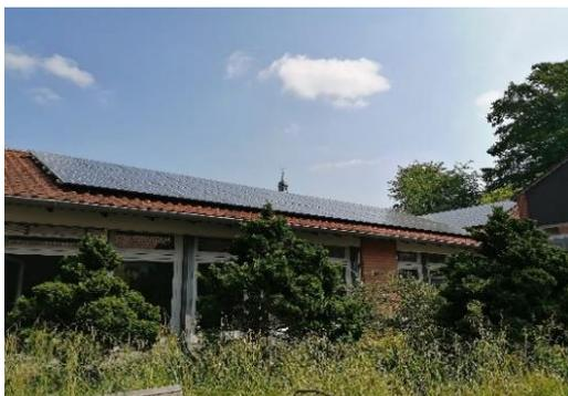
Anfang März ging die Photovoltaikanlage auf den Dächern des DiCV am Hildesheimer Moritzberg in Betrieb und speiste seitdem 72.000 kWh ins Netz ein. Die Anlage hat eine Generatorfläche von 503,6 m<sup>2</sup> und umfasst 281 Module. Durch die Photovoltaikanlage werden rund 51 Tonnen an CO<sub>2</sub>-Emissionen vermieden.
